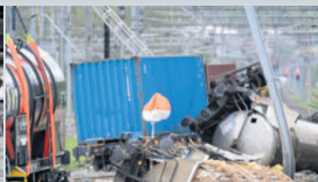
Une installation provisoire remplacera les poteaux portant la ligne de contact.
