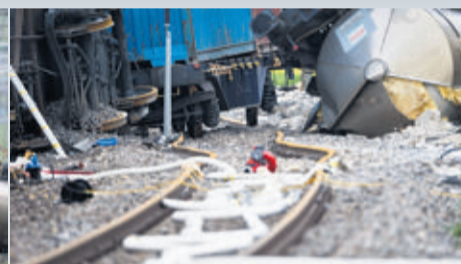
Outre les aiguillages, environ 600 mètres de rails seront remplacés.
