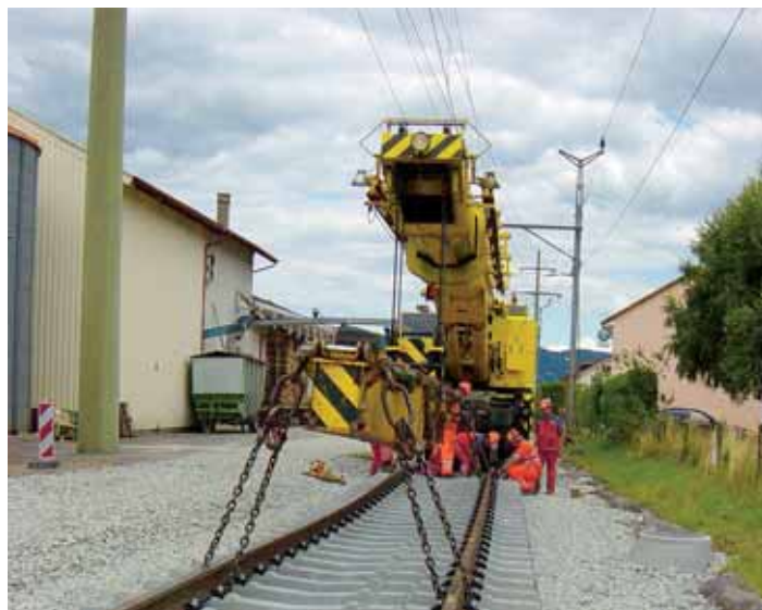
Pose des traverses en vue du troisième rail. (photo J.-F. Milani)
