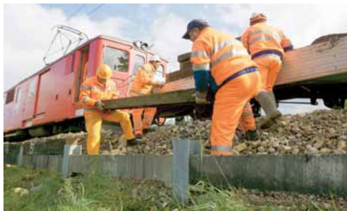
Travaux de voie par une équipe de l'infrastructure (photo cj)
